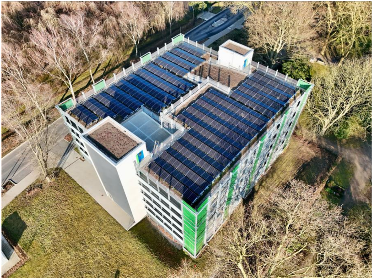
Bild 6: PV-Anlage auf der Quartiersgarage Feldmark
