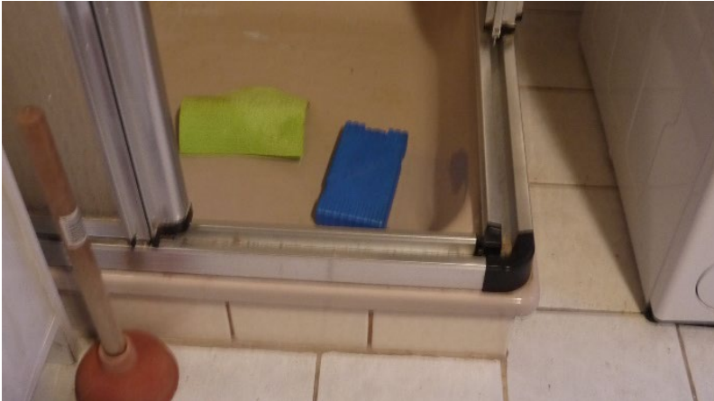
geförderter Umbau eines Badezimmers
