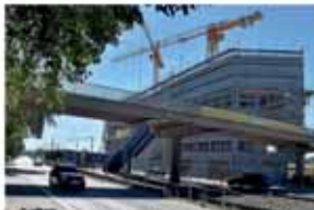
Anfang 2023 soll die Fußgängerbrücke an der Wittener Straße abgebrochen werden. Künftig soll die Straße zwischen Laer (3.) und Mark 51/7 (2.) ebenerdig überquert werden. (302/310/311)
