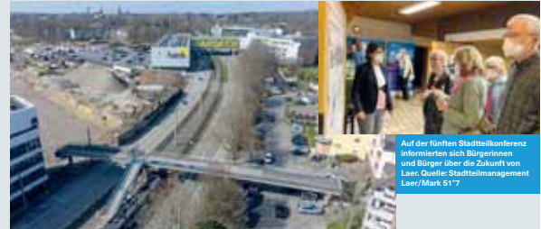
Bald weg: Die Brücke wird durch einen Fußgängerüberweg mit Ampel ersetzt. Quelle: Stadt Bochum
