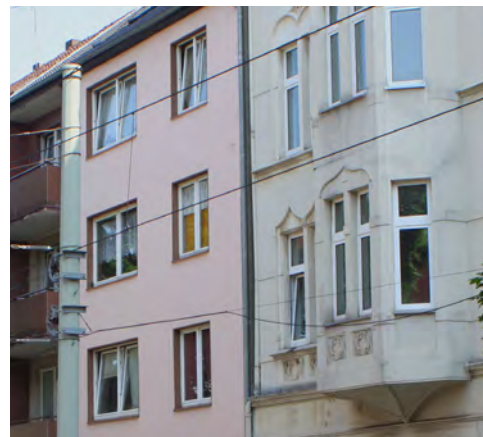
Abb. 166: Fassadenfarbe entspricht dem Farbspektrum in Gestaltungszone II
