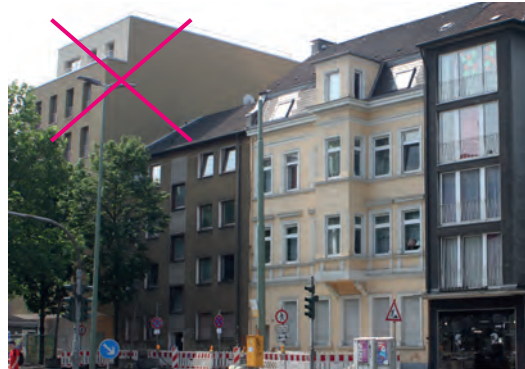
Abb. 140: fehlende gemeinsame Traufhöhe und Dachform
