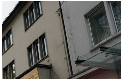
Abb. 85: Verkabelungen sichtbar auf der Fassade verlegt
