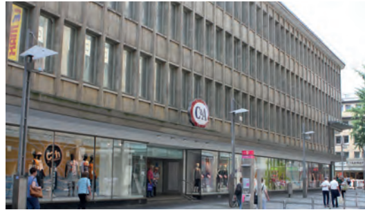
Abb. 29: ehem. Bankgebäude Huestraße
