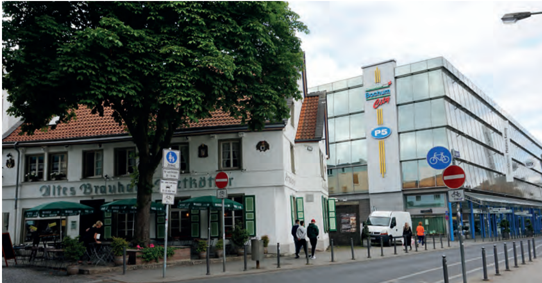
Abb. 120: mangelnde Rücksichtnahme durch spiegelnde Glasfassade und abweichende Maßstäblichkeit
