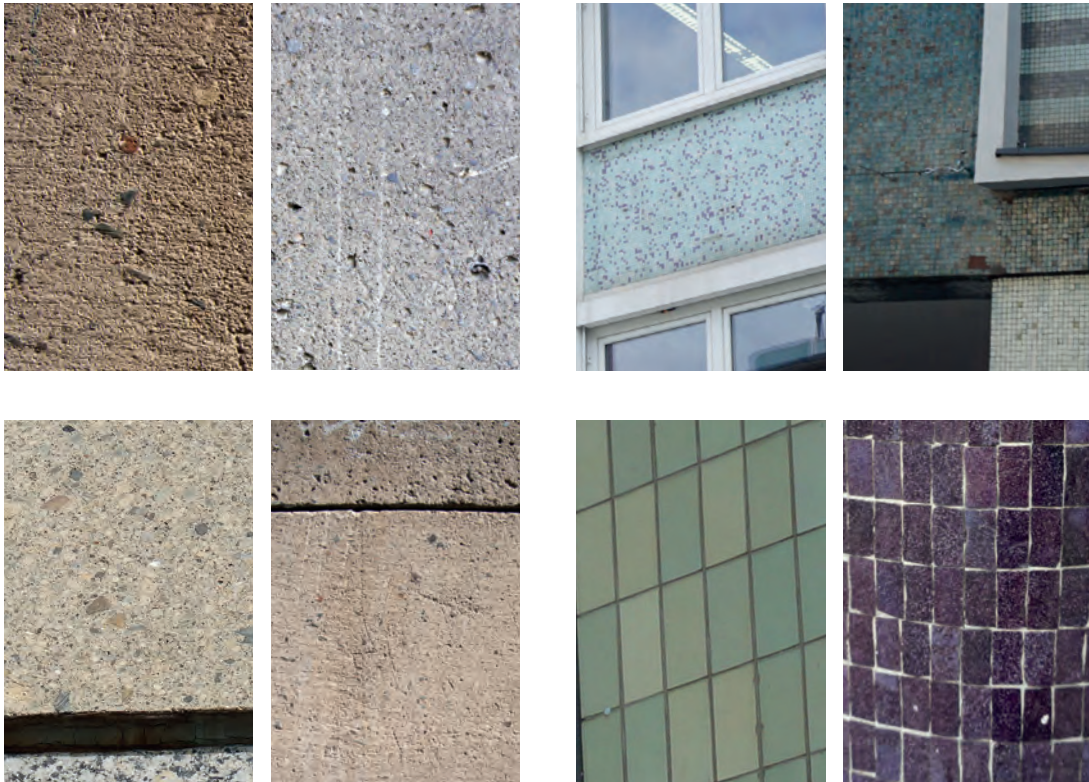
Abb. 158: typisches Fassadenmaterial: Betonwerkstein
