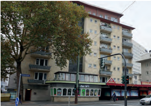
Abb. 8: Denkmal, Wohngebäude Ecke Viktoriastraße/Südring
