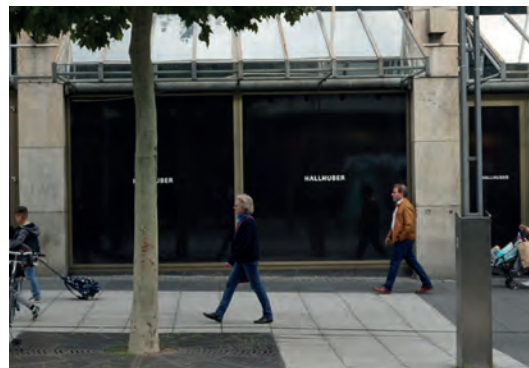
Abb. 237: dauerhafte Beklebung, keine Schaufensterwirkung
