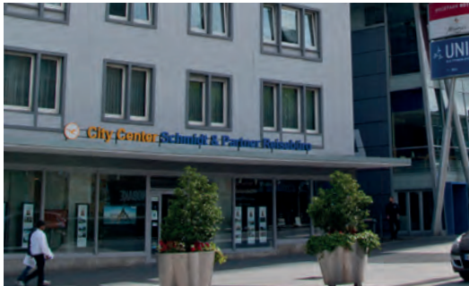
Abb. 229: für die Anbringung von Werbeanlagen geeignetes Vordach
