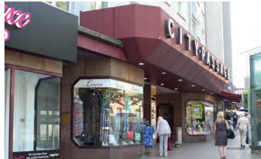
Abb. 230: ungewollte Kombination von Werbeanlage und voluminösem Vordach
