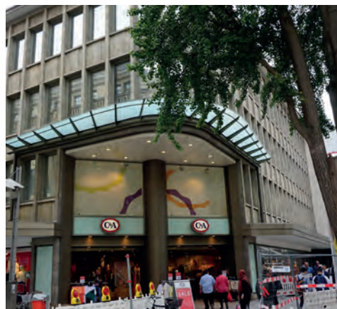
Abb. 191: überdimensionierte Fassadenöffnung, großer Geschäftsbau
