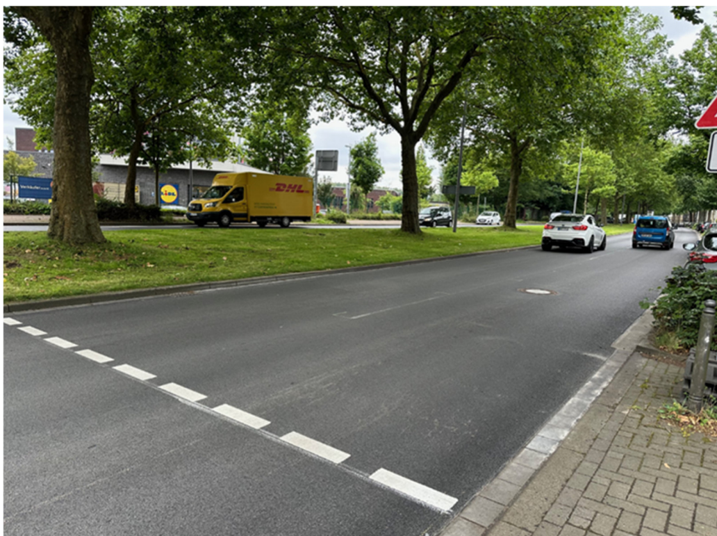
Abbildung 14: Kohlenstraße, sanierte Fahrbahndeckschicht mit Splittmastixasphalt (SMA 8)
