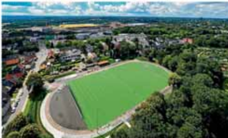
Der neue Kunstrasenplatz wird sich an der Hübnerwehler Straße in Laer für den Fußballverein LFC Laer öffnen. Der Club hat große Pläne.
