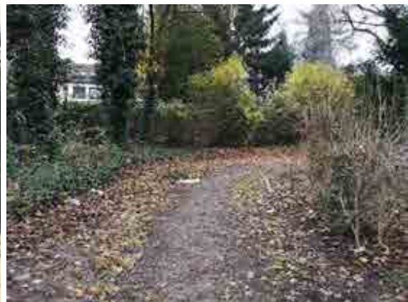
Abbildung 33: Unzureichend befestigter und unbeleuchteter Weg zwischen Werner Hellweg und Gorch-Fock-Straße
