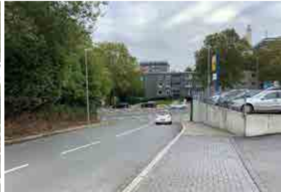
Abbildung 48: Lichtsignalanlage Sudbeckenpad (Einfahrt Lidl)
