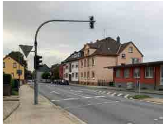
Abbildung 46: Lichtsignalanlage Havkenscheider Straße
