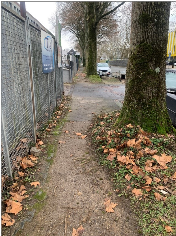
Bild 9: Einengung des Gehwegs durch einen Baum auf der Frenkingstraße (Foto: IGS mbH)
