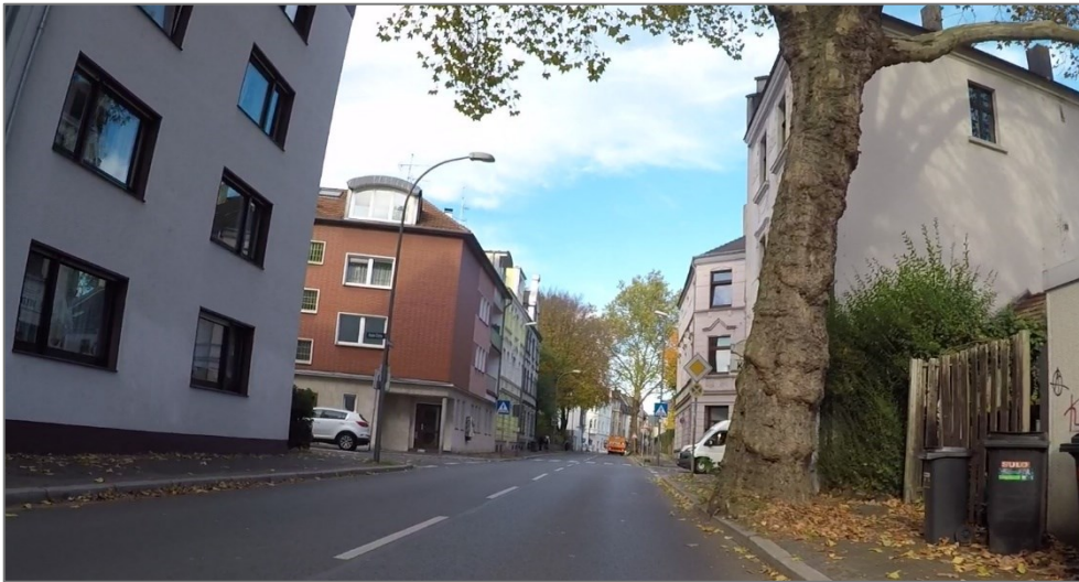
Bild 10: Unebenheiten auf dem Gehweg Lünsender Straße (Foto: IGS mbH)
