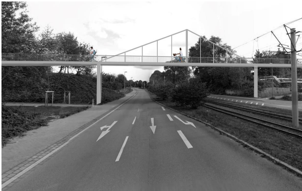
Abb. 36: Fuß- und Radwegebrücke Lothringentrasse/Castroper Hellweg
