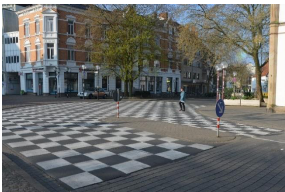
Abb. 20: Flächige Markierung eines Kreuzungsbereichs (Osnabrück)
