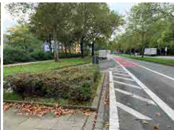
Abbildung 50: Werner Hellweg, Rechtsabbiegespur Richtung Laerfeldstraße
