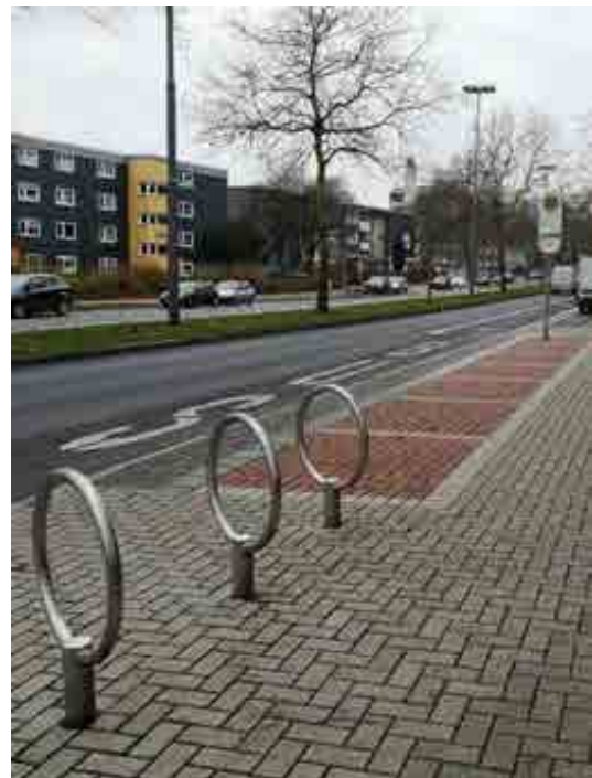
Abbildung 39: Abstellanlagen an Bushaltestellen entlang des Werner Hellwegs
