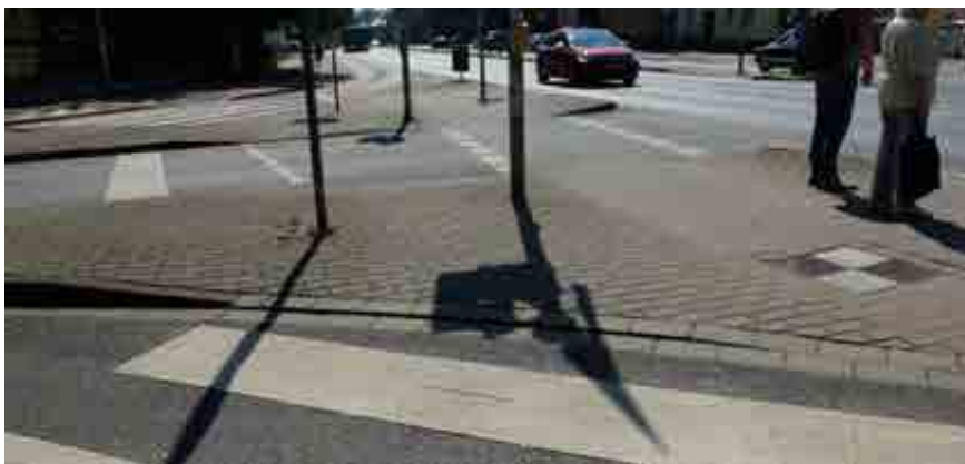
Abbildung 10: abgesenkter Bordstein (3cm) inkl. Nullabsenkung für den Radverkehr
