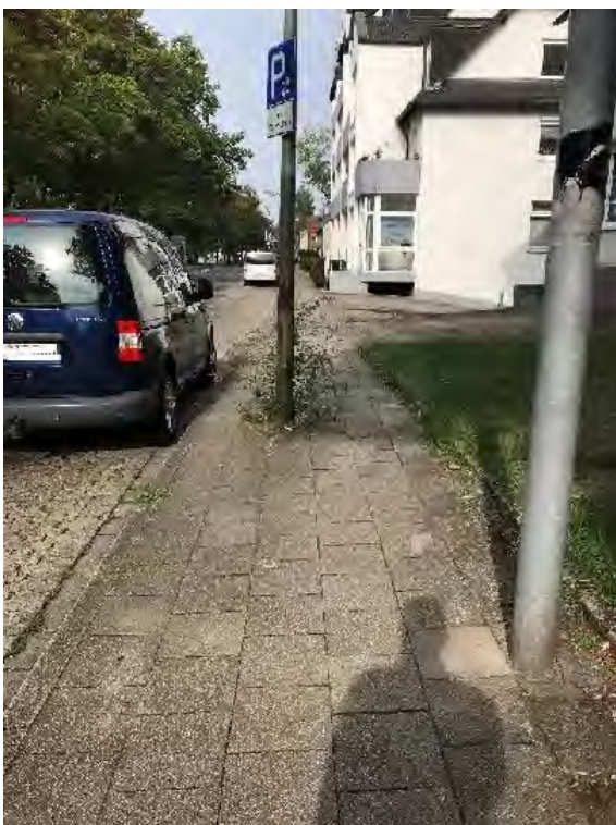
Bild 13: Einengung des Gehwegs durch einen Laternenmast auf der Propst-Hellmich-Promenade (Foto: IGS mbH)
