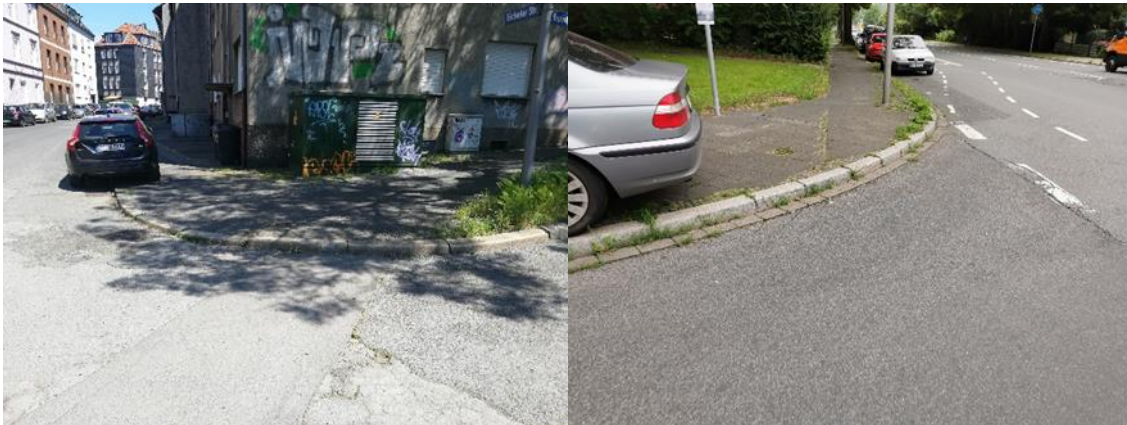
Abbildung 11: Unterschiedliche Höhen der Bordsteinkanten an Querungsstellen
