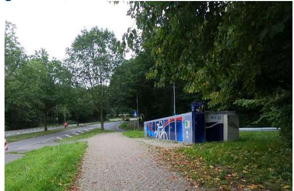
DeinRadschloss-Anlage - U-Bahn Station Hustadt, Bochum
