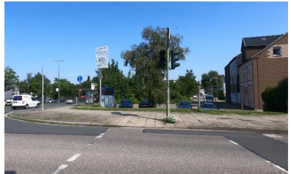
Nicht abgesenkter Bordstein Knotenpunkt Berliner Straße/ Wilhelm-Leithe-Weg, Bochum
