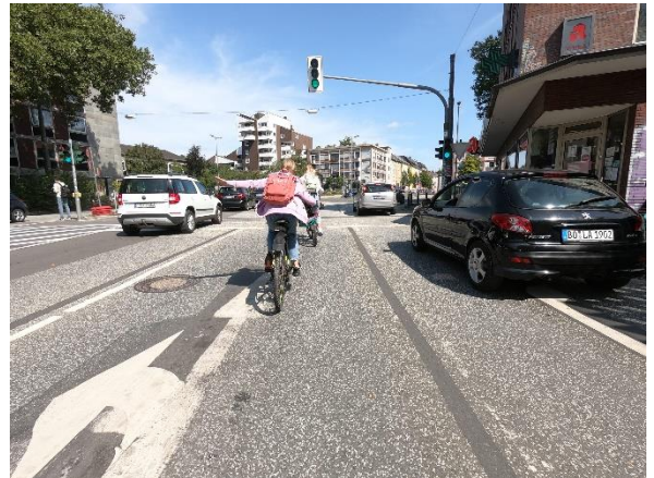
Unübersichtlicher Knotenpunkt Hattinger Straße/ Königsallee, Bochum (wird bereits umgebaut)
