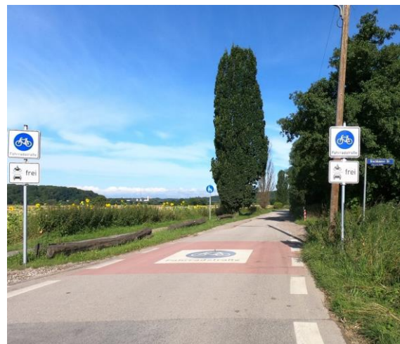
Fahrradstraße, Brockhauser Straße
