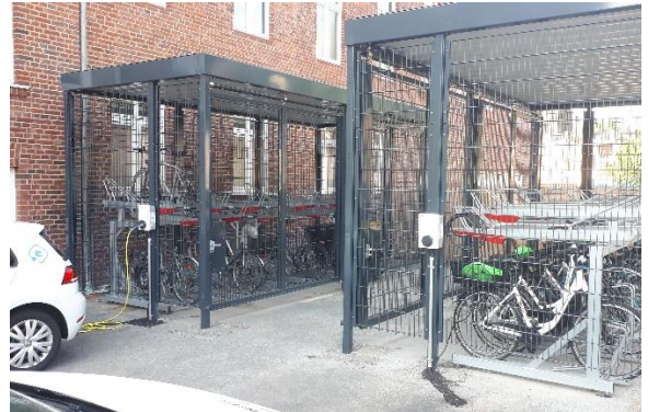
Gesicherte Abstellanlage für Beschäftigte mit Doppelstockparkern und angrenzenden Stellplätzen für Elektroautos, Münster
