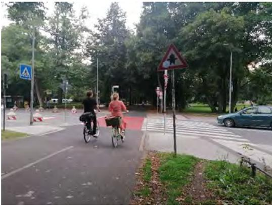
**Abbildung 21: Bevorzugung von Rad- & Fußverkehr mittels visuellen und baulichen Elementen**
