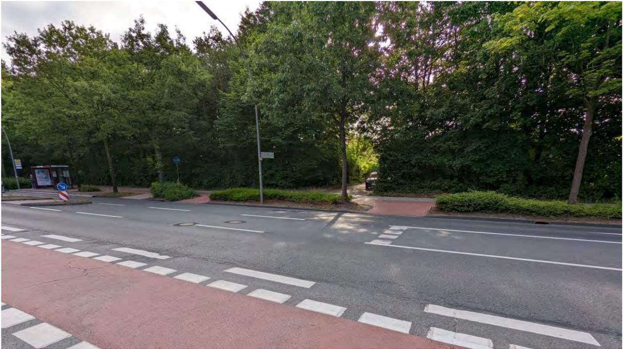
Abbildung 18: Absenkung und Führung über den Grünstreifen für direktes Abbiegen
