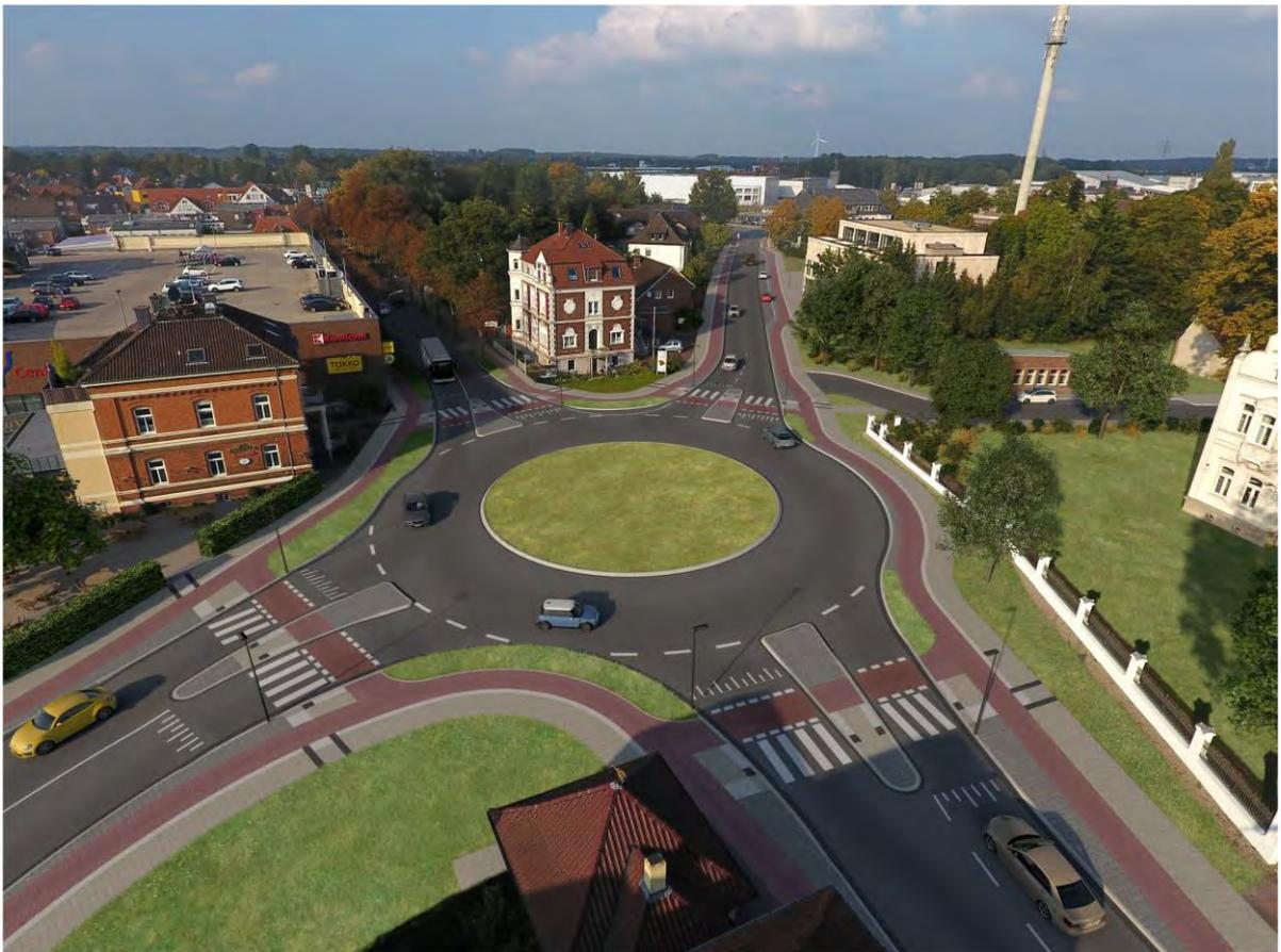
Abbildung 20: Radverkehrsführung an einem Kreisverkehr, Borken
