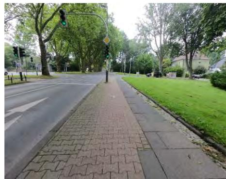
Abbildung 39: Unebenheiten in der Oberflächenbefestigung (links) und Signalmast auf Radweg (rechts)
