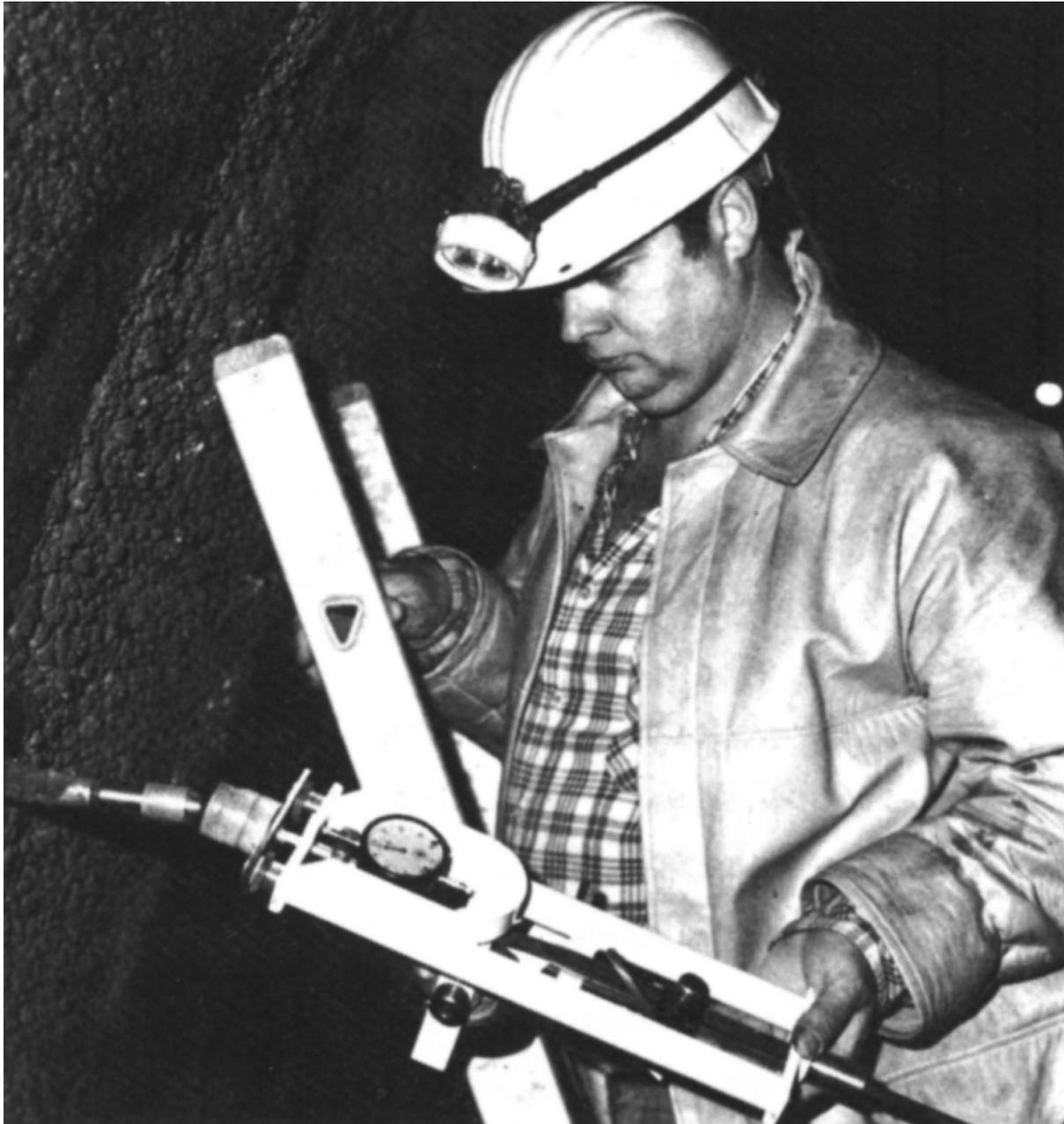
**Abbildung 9: Konvergenzmessung im Tunnelbau**
