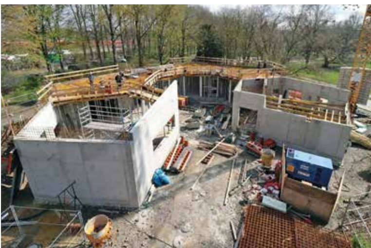
Das KJFH „Inpoint“ Langendreer in der Bauphase Frühjahr 2021
