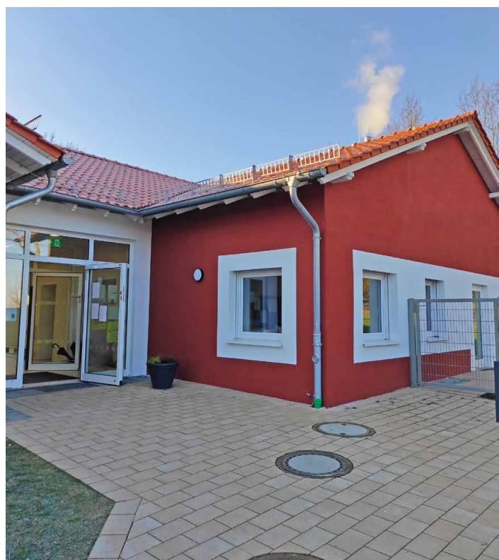
Außenansicht des Erweiterungsbaus Kita Stockumer Straße
