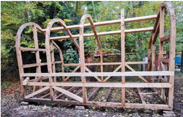
Die Honigwerkstatt im Rohbau
