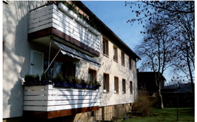
Balkone an der Rückseite eines Gebäudes an der Lerschstraße
