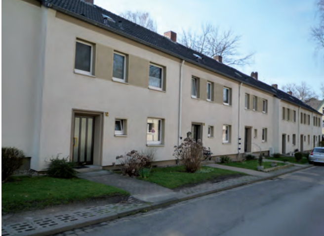
Zweigeschossige Reihenhäuser, Brandenburgstraße
