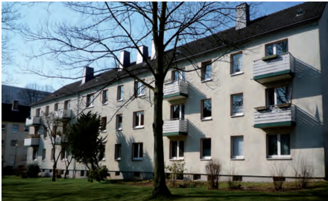
Dreigeschossiges Mehrfamilienhaus des Typs 29/12/13, Baarestraße
