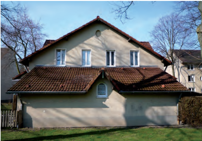
Eingeschossiger Anbau des Mülhauser Typs
