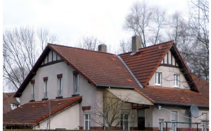
Fachwerkelemente in den Giebfeldern des Mülhauser Typs
