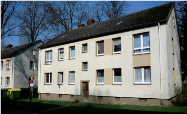
Zweigeschossiges Mehrfamilienhaus des Typs 3G2, Brandenburgstraße
