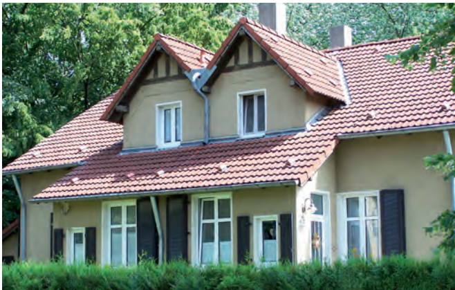
Gebäude des Mülhauser-Typs
