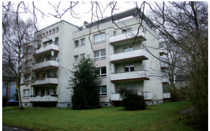
Mehrfamilienhaus an der Baarestraße 61
