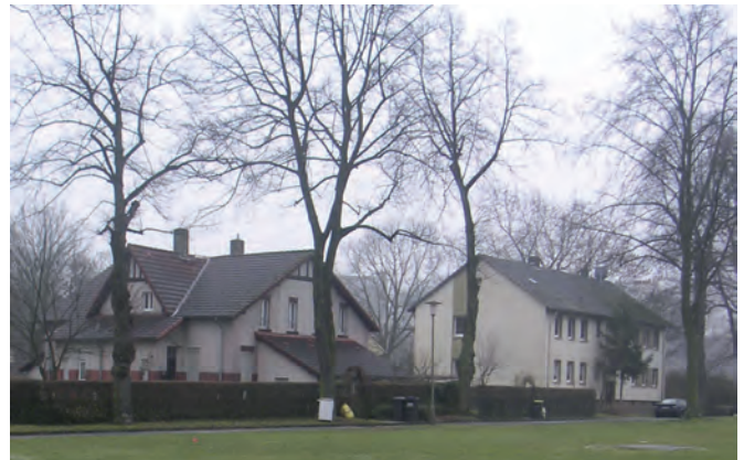
Nebeneinander von Gebäudetypen unterschiedlicher städtebaulicher Leitbilder
