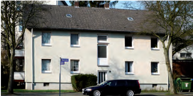
Dachfläche mit Luken
