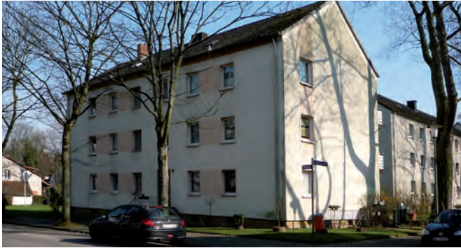
Ausgangslage: keine Balkone
