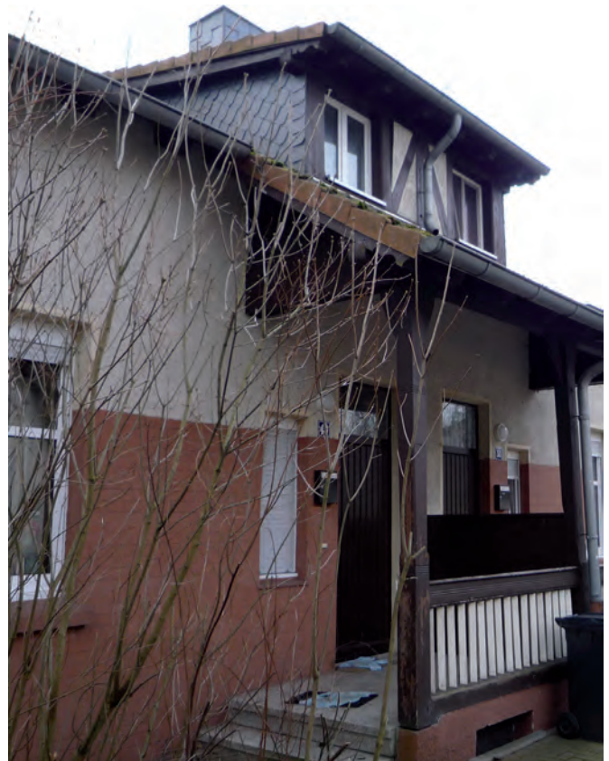
Eingangsloggia in Holz und Klinkerflächen
