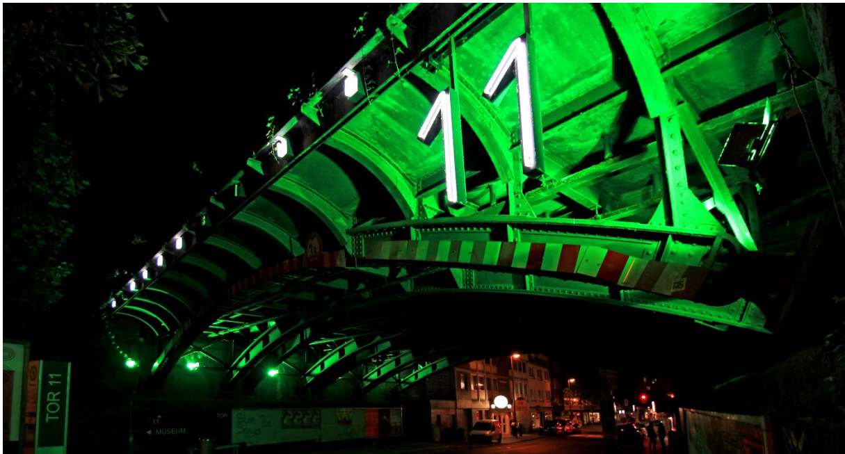
(Industriedenkmal Eisenbahnbrücke Körtumstraße, Kunstlichttor 11)
