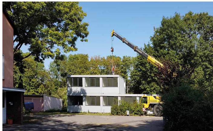
Der Abbau der Bürocontainer am Bodelschwingplatz
