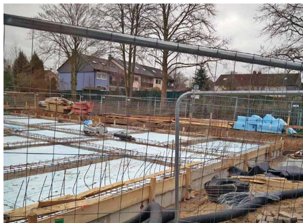
Die Anbauarbeiten an der Herzogstraße
