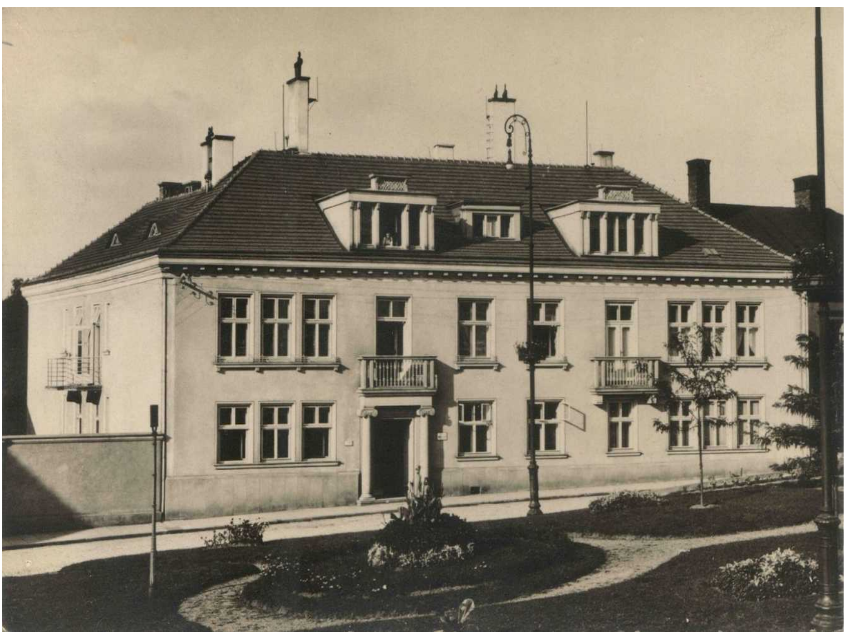
Das Haus am Theaterplatz 6, erbaut 1932-33, Architekt: Alfred Wiedermann. Das Foto ist ca. 1933-35 entstanden.
