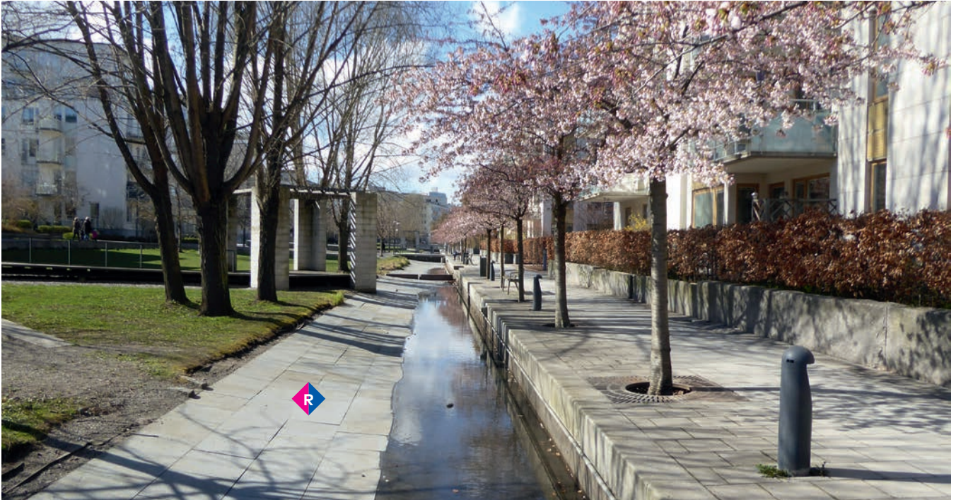
Sammeln und schadfreies Ableiten von Niederschlägen im Quartier.
