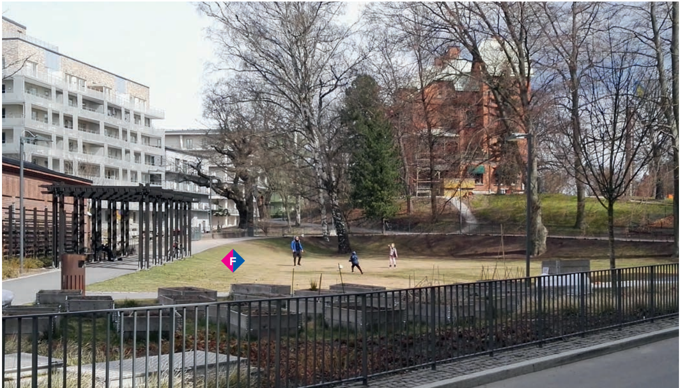
Multifunktionale Flächennutzung: Bei starken Regen kann Wasser auf dieser Grünfläche gesammelt werden.
