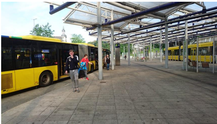
Abbildung 3: Der Verknüpfungspunkt Steele bietet Umsteigemöglichkeiten zwischen S-Bahn, Straßenbahn und mehreren Buslinien.
