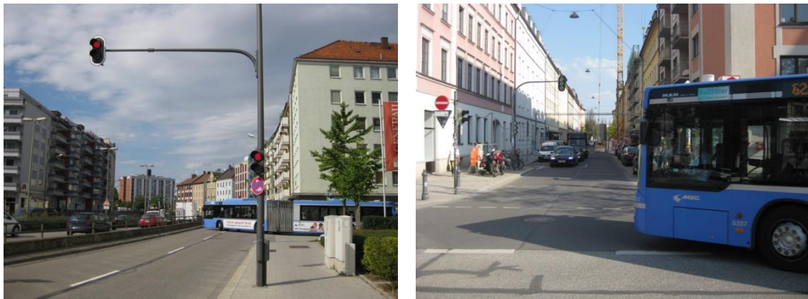
Abbildung 86: Abfangsignalisierung (linkes Bild; Beispiel: München) und Engstellensignalisierung (rechtes Bild; Beispiel: München)
