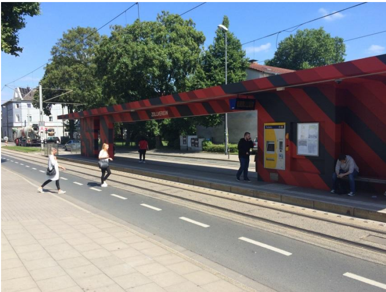
Abbildung 29: Die Haltestelle „Zollverein“ wurde 2010 zum Kulturhauptstadtjahr barrierefrei umgebaut und gestalterisch aufgewertet.
