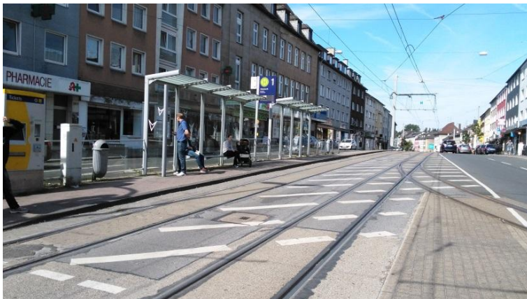
Abbildung 49: Straßenbahnhaltestelle Helenenstraße (Mängel: zu schmale Seitenbahnsteige und kein niederflurgerechter Bord)
