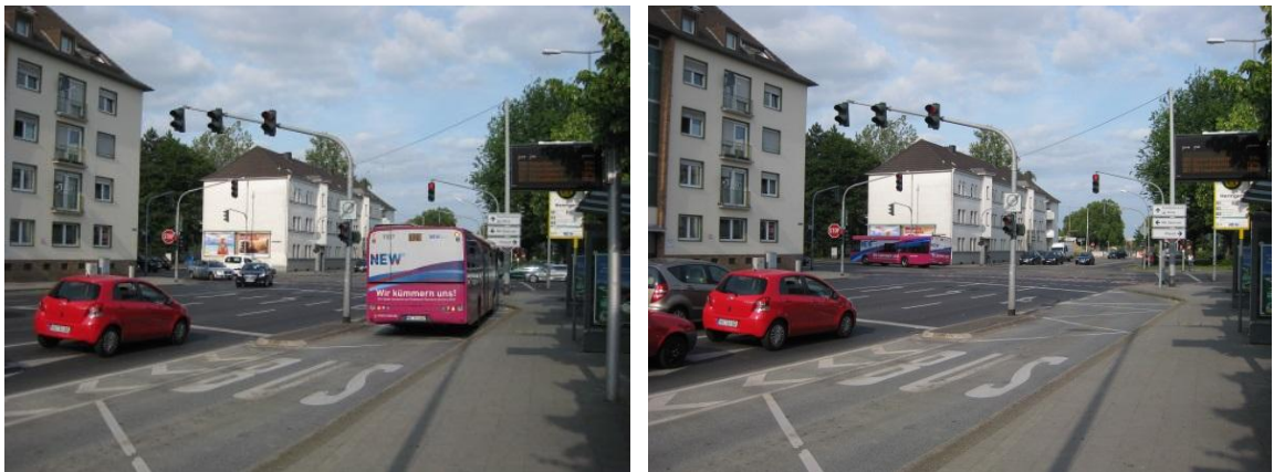
Abbildung 85: Busschleuse an einem Knotenpunkt mit Haltestelle für linksabbiegenden Bus (Beispiel: Mönchengladbach)
