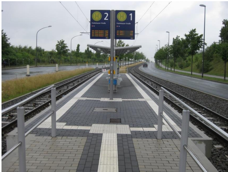
Abbildung 61: Durchgängiges taktiler Leitsystem an Haltestelle mit Mittelbahnsteig (Beispiel: Haltestelle Frohnhauser Straße)
