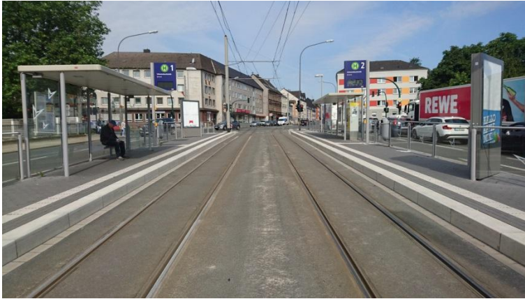
Abbildung 39: In Essen wurden in den letzten zehn Jahren nur wenige Straßenbahnhaltestellen barrierefrei ausgebaut (Beispiel: Haltestelle Schwanenbuschstraße).
