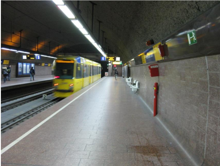
Abbildung 1: Im Südtunnel verkehren Stadtbahn und Straßenbahn im Mischverkehr (Drei-Schienen-Gleis)
