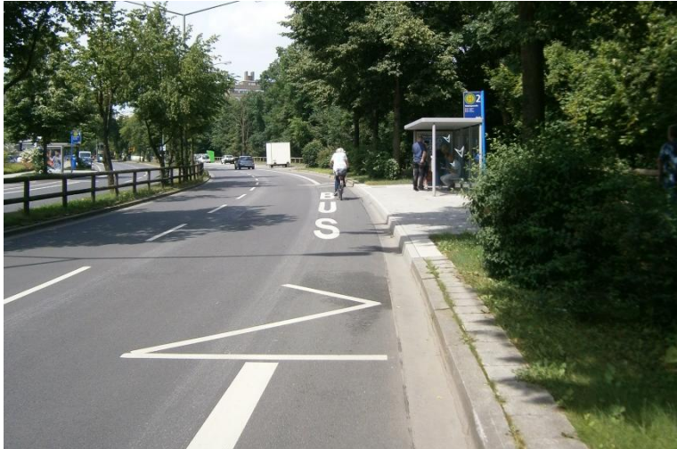
Abbildung 63: Führung des Radverkehrs an Haltestellen über die Fahrbahn (Beispiel Haltestelle Walpurgisstraße; Bildquelle: Ruhrbahn)
