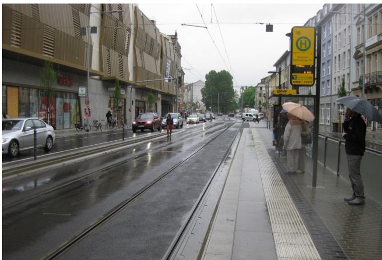
Abbildung 60: Barrierefreie Straßenbahnhaltestelle in begrenzten Platzverhältnissen mit Seitenbahnsteig (rechts) und überfahrbarem Haltestellenkap (links) (Beispiel: Dresden Haltestelle Bautzner/ Rothenburger Straße)
