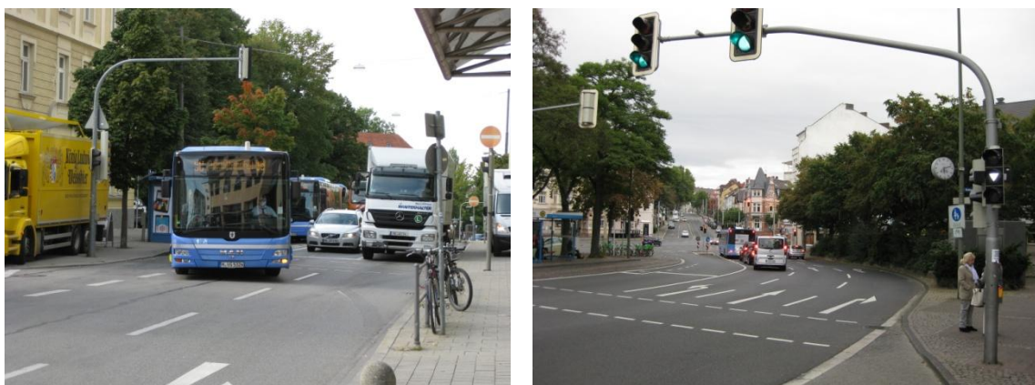
Abbildung 87: signalgesicherter Fahrstreifenwechsel vor Knotenpunkt zur Absicherung der störungsfreien Fahrt auf die Linksabbiegerspur (Beispiele: München (links) und Kassel (rechts))
