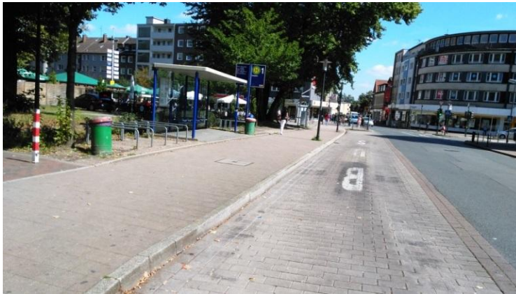
Abbildung 46: Der Verknüpfungspunkt Karlsplatz ist nicht barrierefrei nutzbar.
