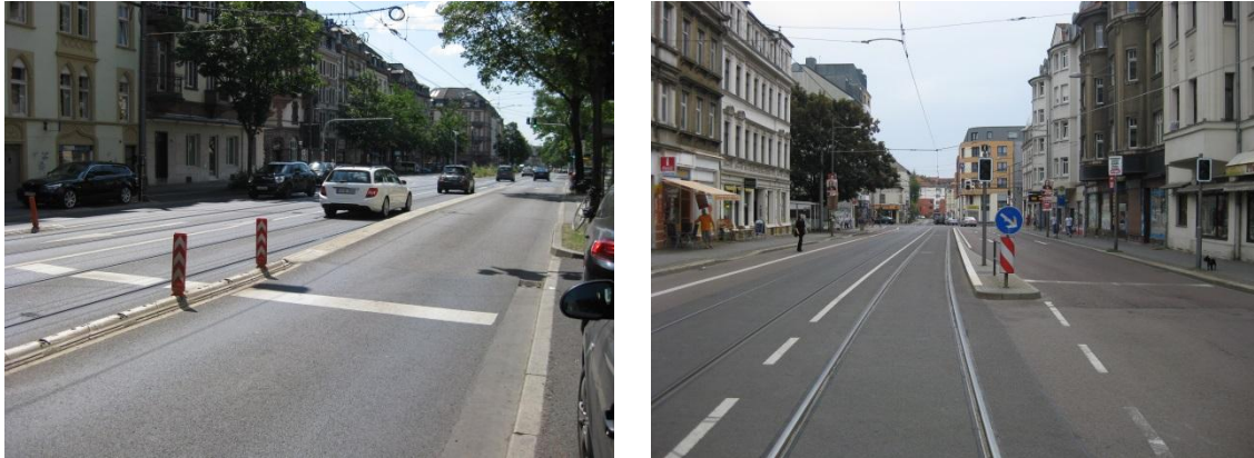
Abbildung 83: Überfahrbares Haltestellenkap: in einer vierspurigen Hauptverkehrsstraße (linkes Bild; Beispiel: Frankfurt am Main) und im Knotenpunktsbereich der MIV-Aufstellspuren (rechtes Bild; Beispiel: Leipzig)
