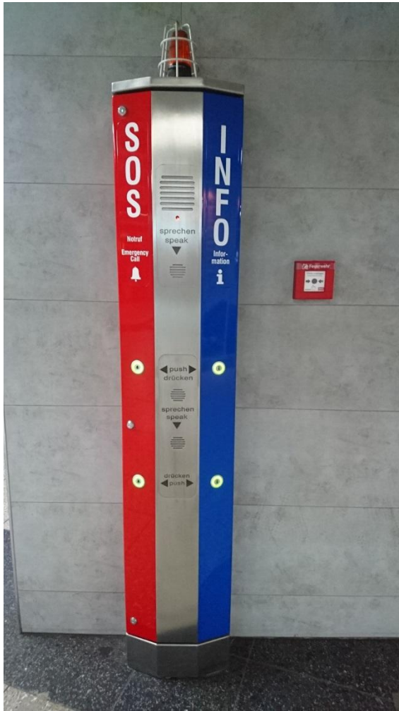
Abbildung 4: Notrufsprechstelle mit gleichzeitiger Funktion als Info-Sprechstelle
