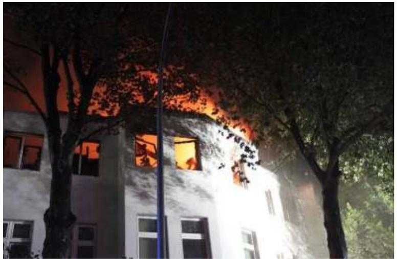
Aufgrund der baulichen Umstände stürzte das Flachdach im Brandbereich schon in einer sehr frühen Einsatzphase ein, so dass sich der Brand auf die noch nicht betroffenen Abschnitte des Flachdachs ausbreiten konnte. Daraufhin mussten sich die Einsatzkräfte zurückziehen und sich auf die Brandbekämpfung von außen über drei Drehleitern beschränken.
