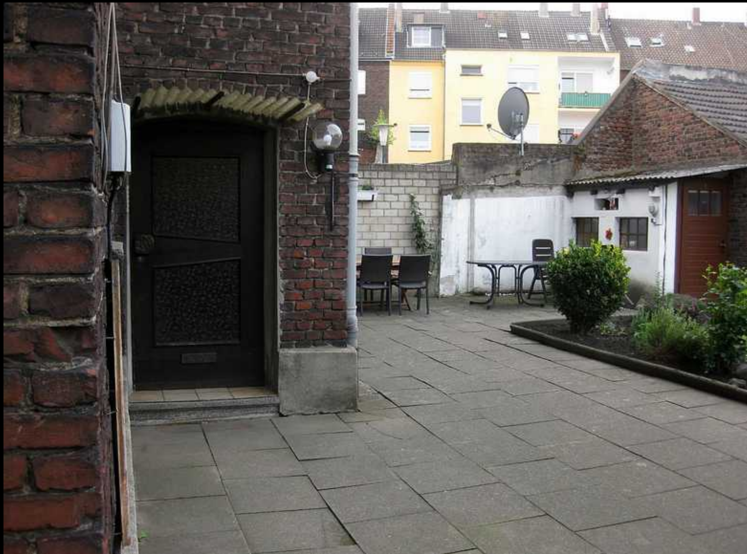
Im Gang zwischen den Häusern Langestraße 5 und 7 befindet sich die Haustür.
