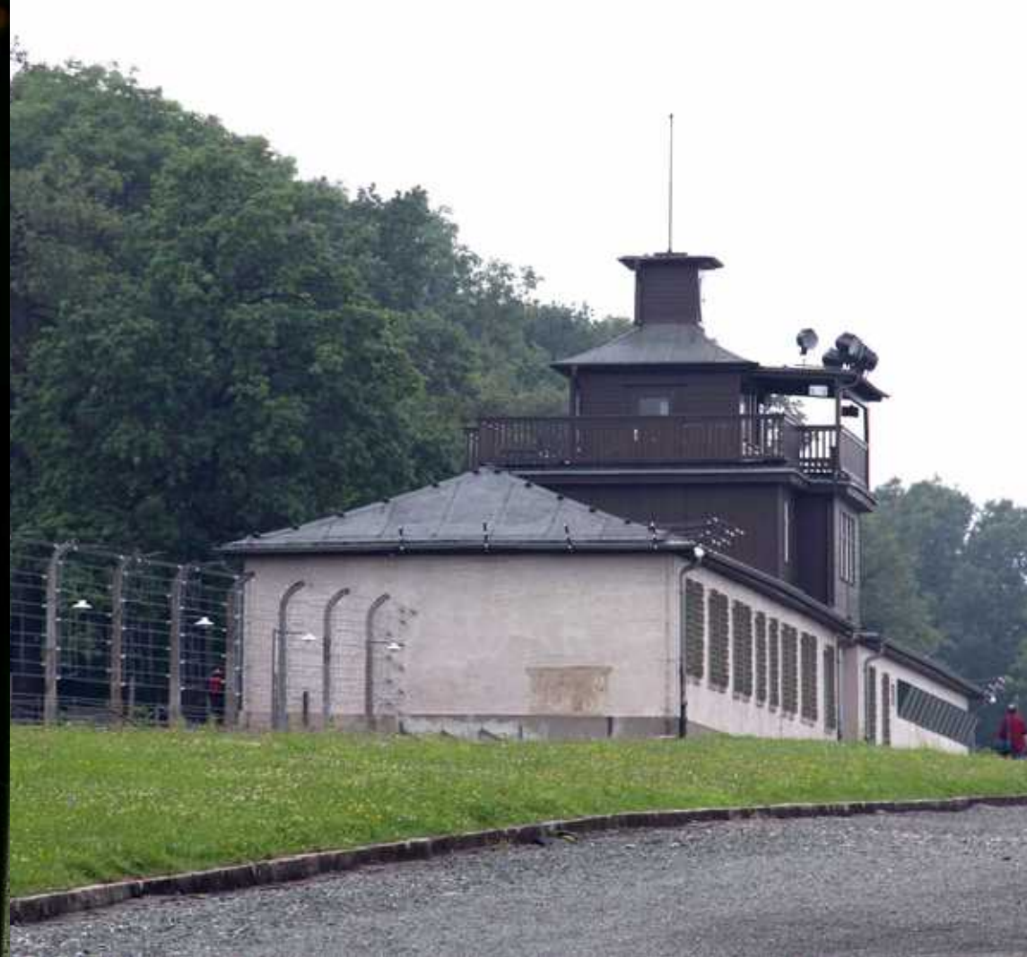
Bilder vom Torgebäude und dem elektrischen Lagerzaun.
