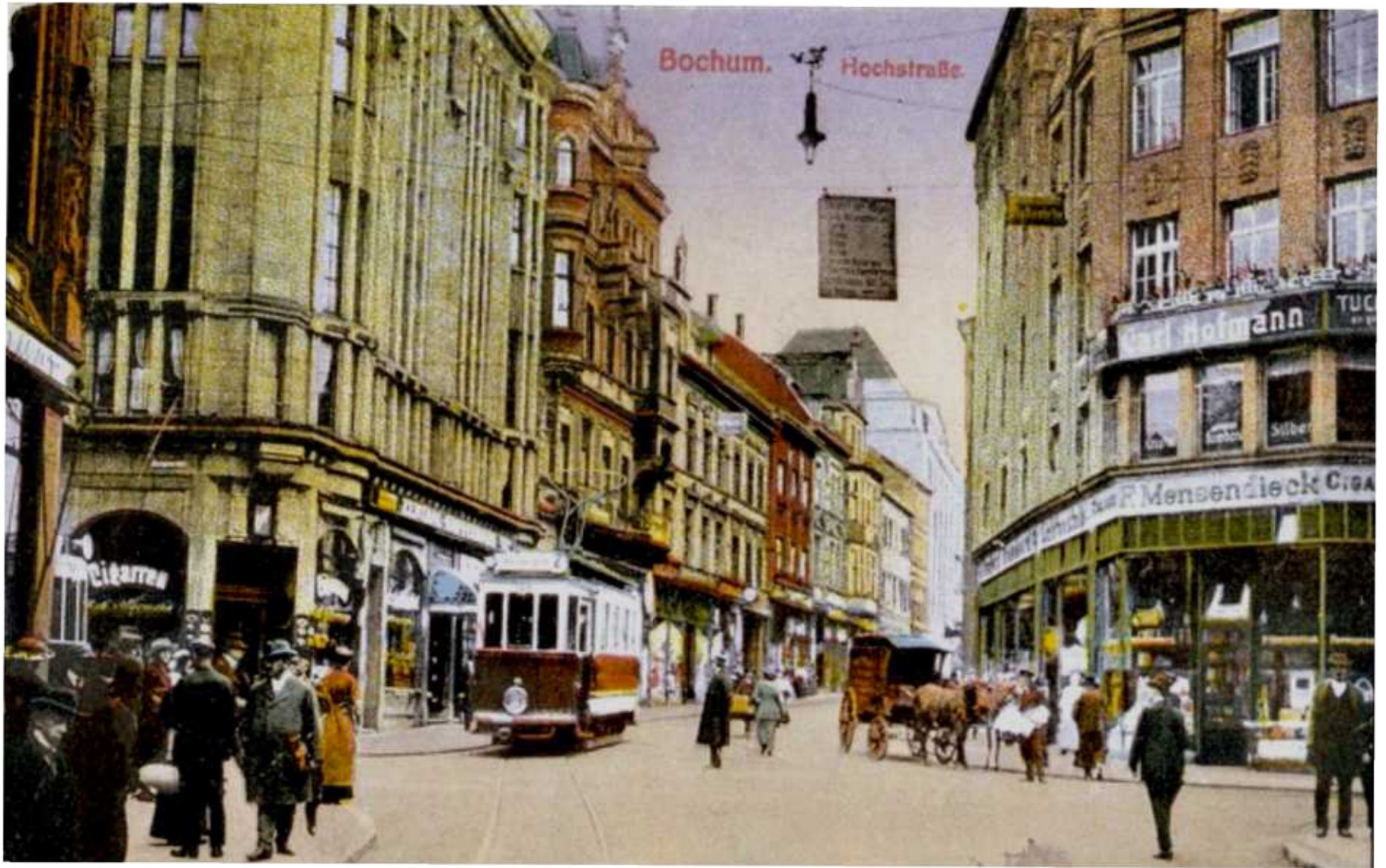
Blick in die Hochstraße, die spätere Kortumstraße, von der Bongardstraße in Richtung Süden. Über der Pferdekutsche erkennt man in der linken Häuserflucht das gelbe Haus Nummer 76 (mit Erker).
