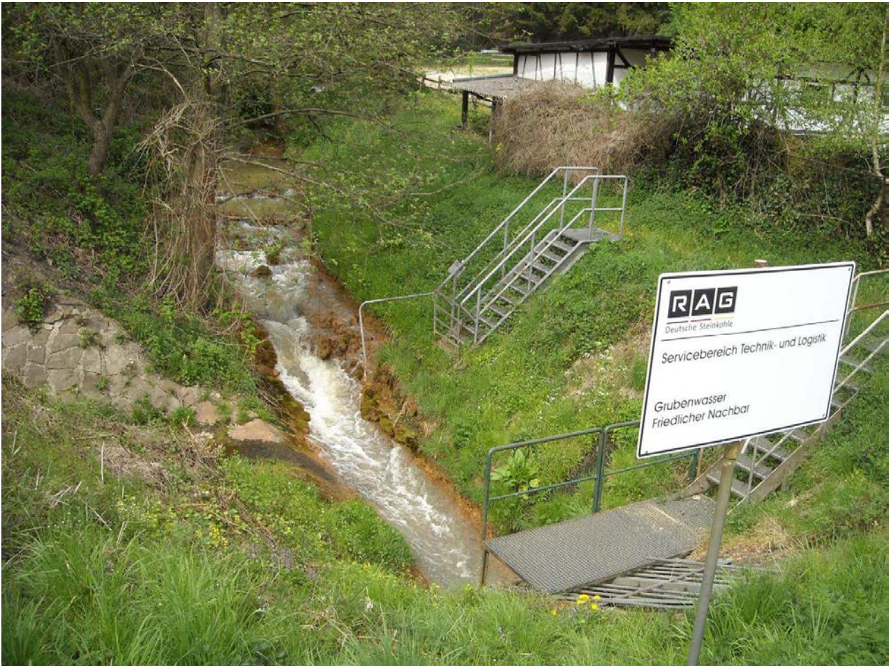
Grubenwasser-Einleitung (Friedlicher Nachbar)
