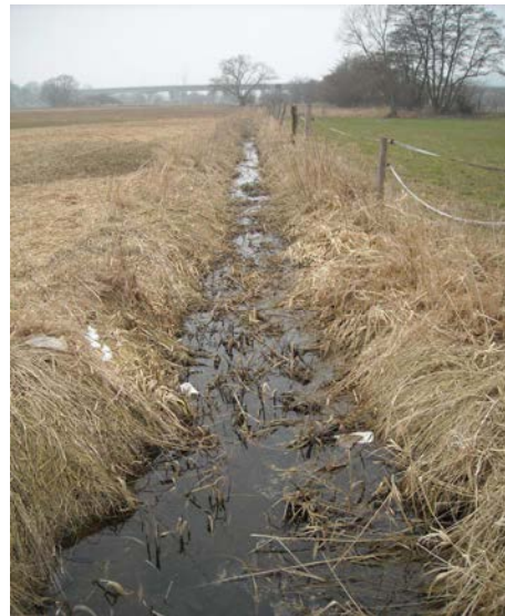
Ranterdeller Bach, nördlich der Brockhauser Straße (naturnah umgebaut), in der Ruhraue
