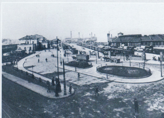
Bahnhof Bochum-Süd - der spätere Hauptbahnhof
