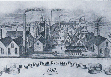
Ideenschmiede mit Zukunft - die Gußstahlfabrik an der Chaussee nach Essen
