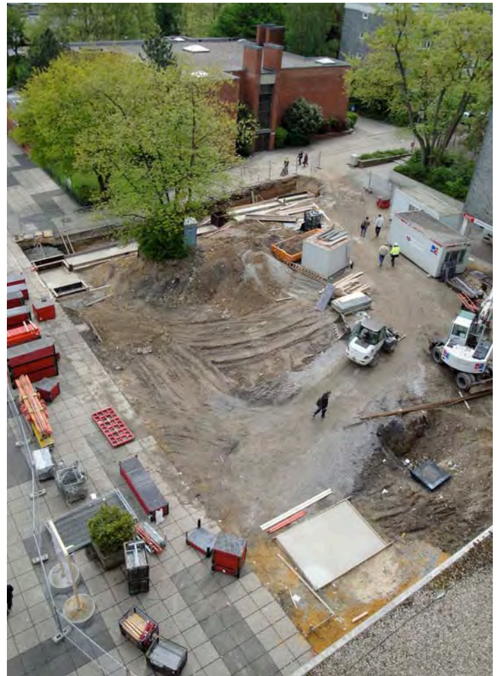
Die Baustelle Brunnenplatz von oben (Foto: Stadtumbaumanagement)
