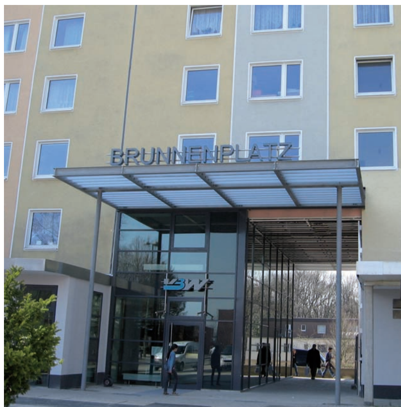
Das neue Tor zum Brunnenplatz (Fotos: VBW Bauen und Wohnen GmbH)
