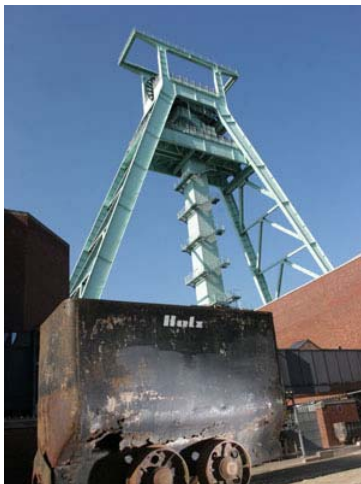
Förderturm mit Kohlenlore
