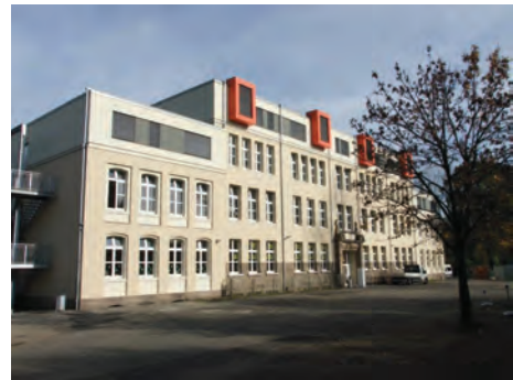
Abbildung 13: Feldsieperstr. 94 Oben: alte Ansicht Unten: neue Ansicht
